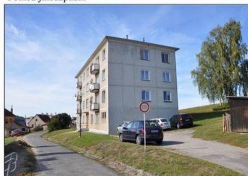
Pohled jihovýchodní – z přístupové cesty
