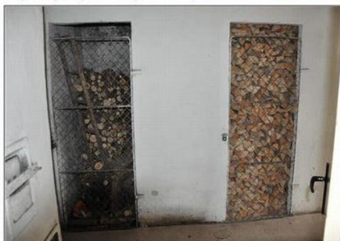
Sklepní zděné kóje
