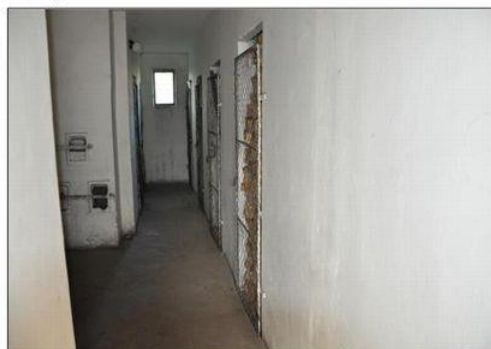
Chodba ke sklepním kójím
