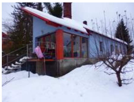
objekt bez č.p. – výměnek
