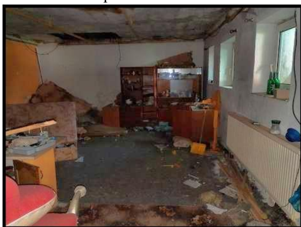
přístavba - letní kuchyň
