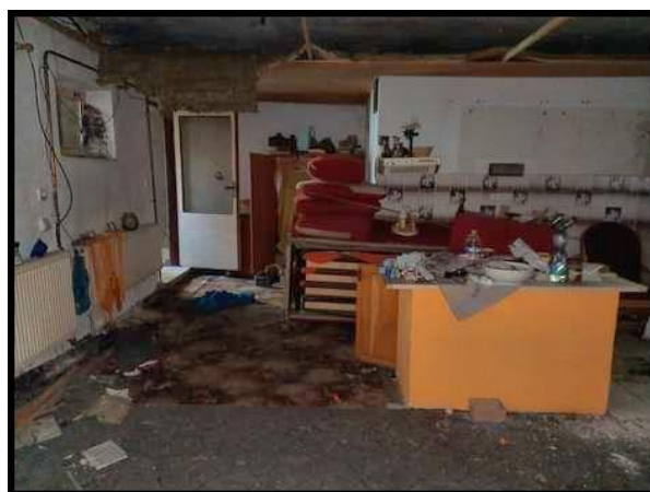
přístavba - letní kuchyň
