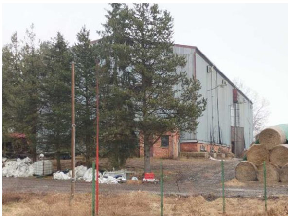
Pohled na zemědělskou stavbu ze Z strany
