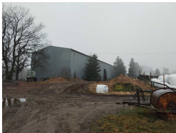
Pohled na zemědělskou stavbu ze SV strany
